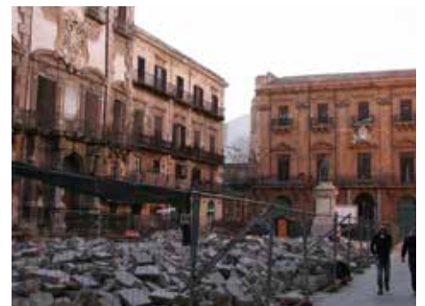
Piazza Bologni in ristrutturazione
